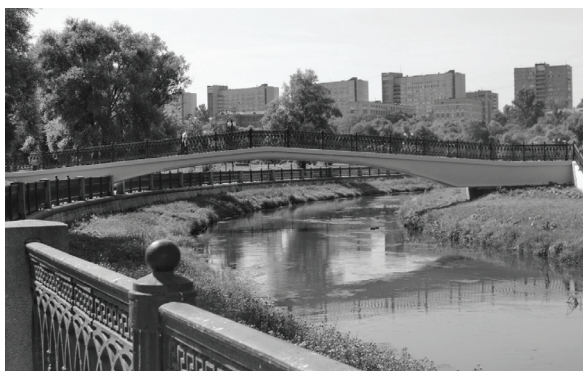
Мост через Яузу в Ростокино. Современный вид
