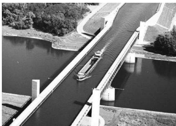
Магдебургский водный мост, Германия
