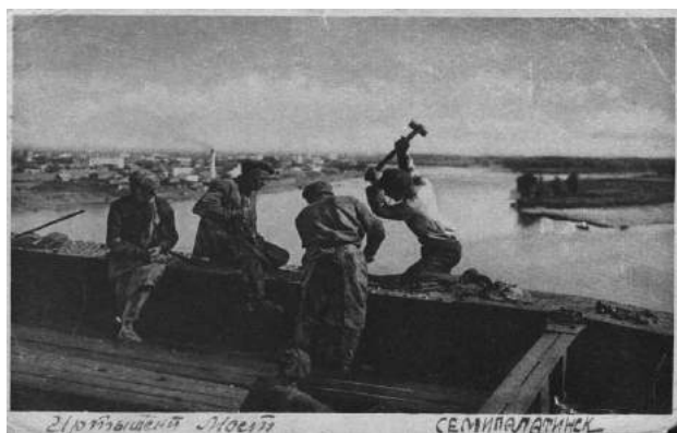
Строительство моста через Иртыш. Фото из архива П.Н. Жукова [8]
