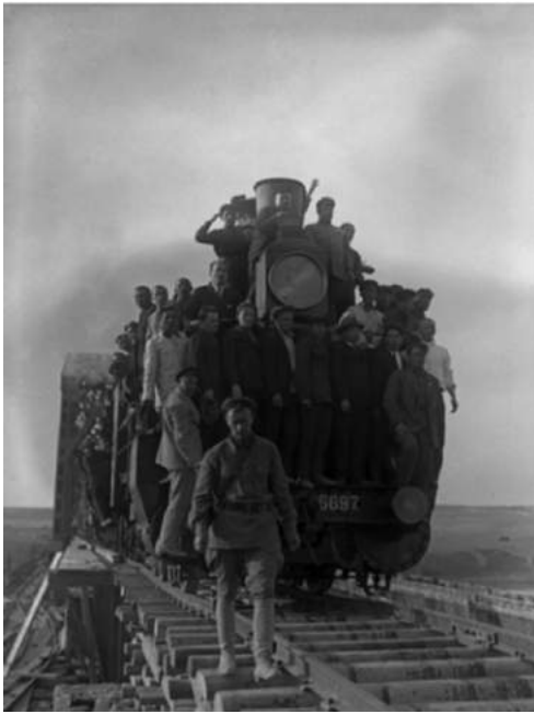
Строительство Турксиба. Первый поезд пересекает стык. Поют «Интернационал». 28 апреля 1930 г. Фото А. Шайхета [9]
