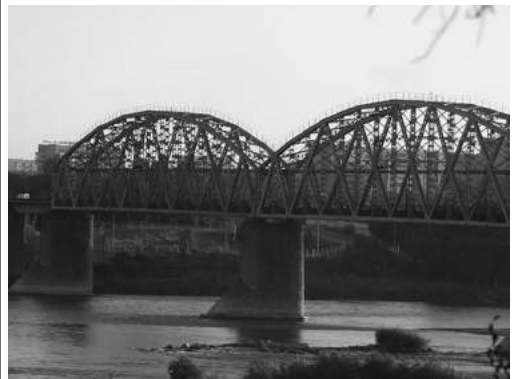
Железнодорожный мост через Иртыш. Семей [10]
