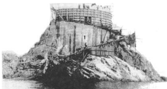
Рис. 2. Строительство маяка Нака-Сиретоко мисаки. Фото 1930-х гг. Архив общества «Тококай», Токио
