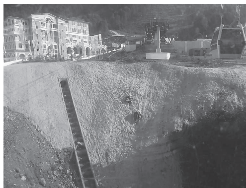
Продолжающиеся строительные работы на территории Верхнего Города Горки (фото автора Мишулиной С.И.)
